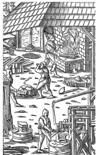
Abbildung 76: Ein Hüttenarbeiter bedient den Streckhammer (Quelle: Agricola 2006, S. 365).
