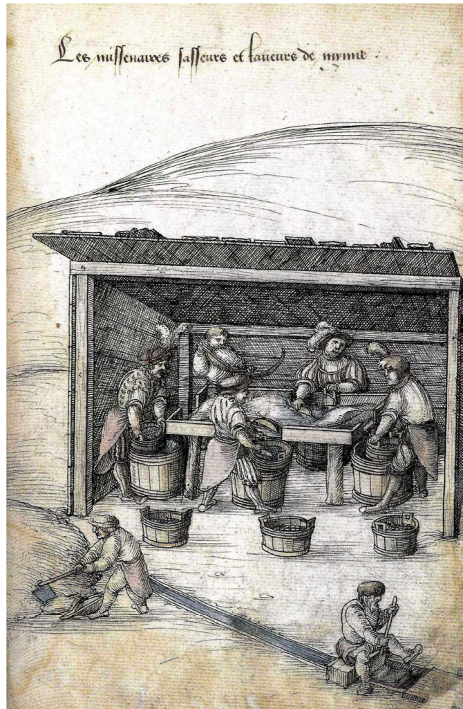
Abbildung 68: Erzwäsche mit Sieben und Waschkässern in den Vogesen nach Heinrich Gross (Brugerolles, [u.a.] 1992, S. 43).
