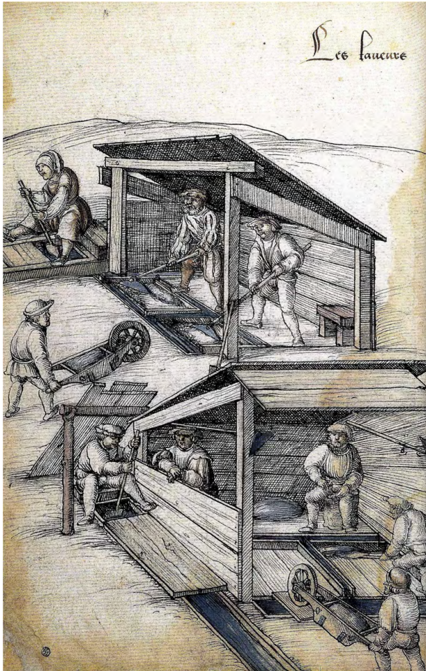
Abbildung 44: Erzwäsche nach Heinrich Gross in den Vogesen (Brugerolles, [u.a.] 1992, S. 40).
