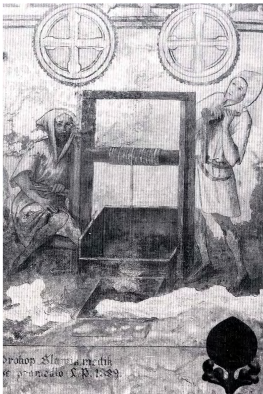
Abbildung 35: Fresken in der Hasplerkapelle aus dem Jahr 1493, St. Barbara Kirche in Kuttenberg (Kutna Hora). Zwei Knappen transportieren mit Hilfe der Haspel Erz aus einem Schacht (Quelle: Slotta, [u.a.] 1990, S. 92).
